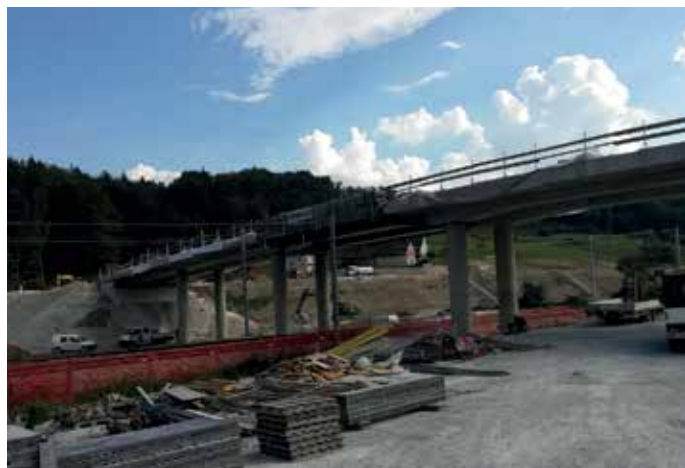
2018, Ogled gradnje nadvoza Breznica
