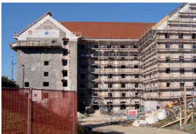
2020, Ogled gradbišča obnova Cukrarne
