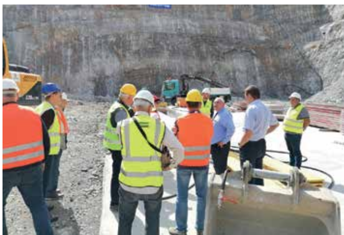
2021, vkop predora na T1 in Viadukt Glinšica
