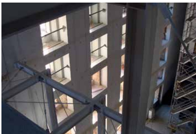
2020, Ogled gradbišča obnova Cukrarne
