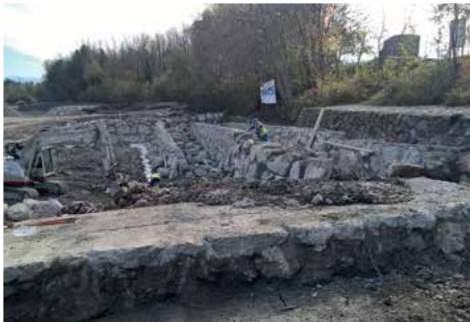
2018, Ogled izvedbe ureditvenih del ob Savinji v območju Nature 2000
