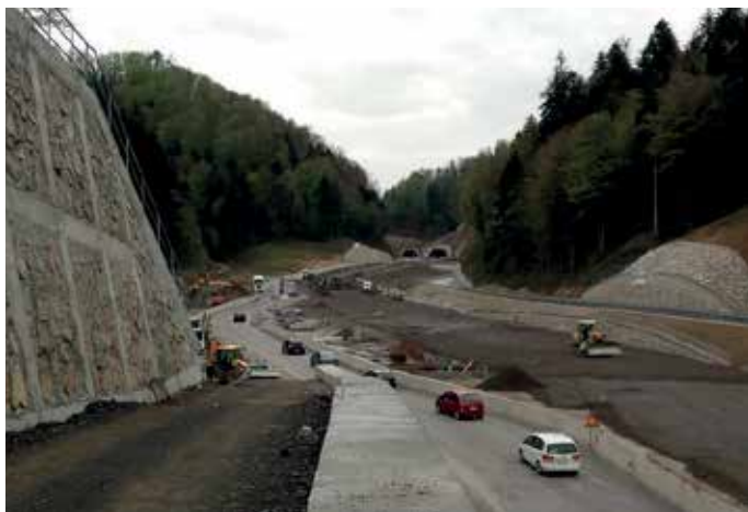
2019, Ogled gradnje ceste G1-9, območje Gruškovja
