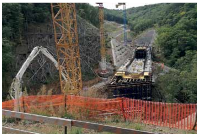
2021, vkop predora na T1 in Viadukt Glinšica
