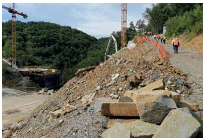
2021, vkop predora na T1 in Viadukt Glinšica
