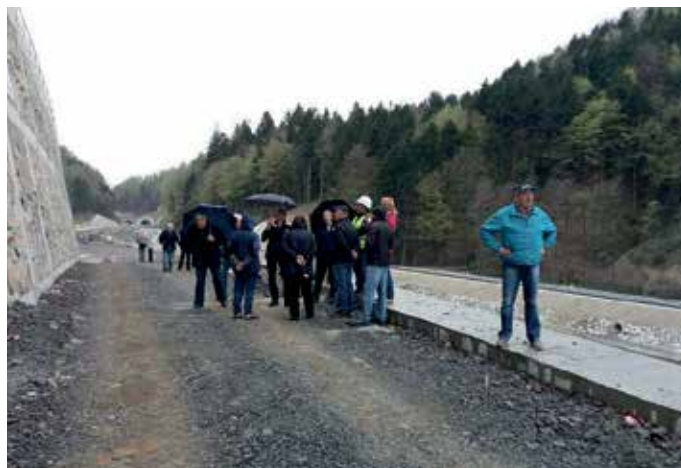
2019, Ogled gradnje ceste G1-9, območje Gruškovja
