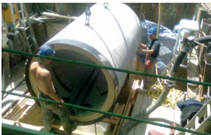
2001, izvajanje hidravličnega podvrtanja
