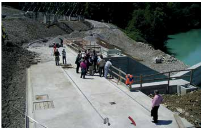
2009, Črpalna elektrarna Avče
