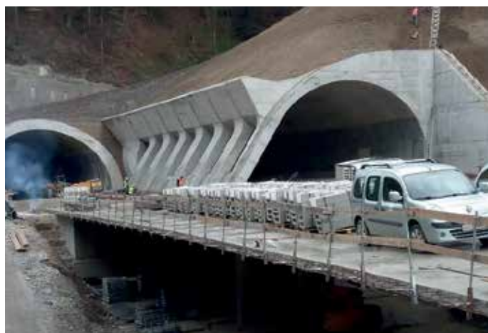
2019, Ogled gradnje ceste G1-9, območje Gruškovja
