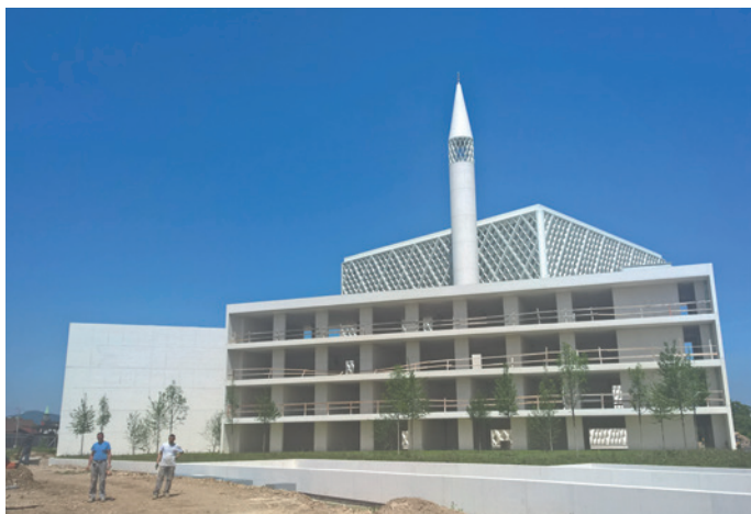
2017, Ogled gradnje Islamskega kulturnega centra
