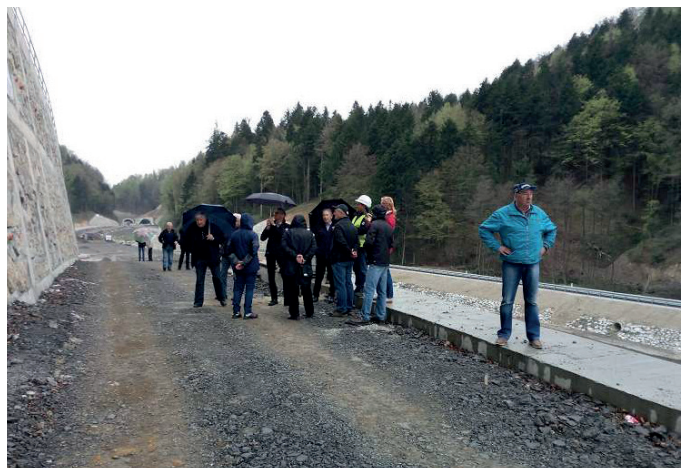
2019, Ogled gradnje ceste G1-9, območje Gruškovja
