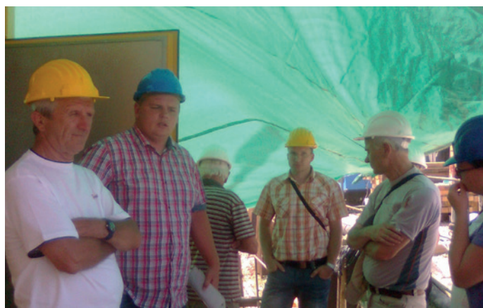
2001, ogled izvajanja hidravlično podvrtanje kanalizacijskih cevi fi 1000
