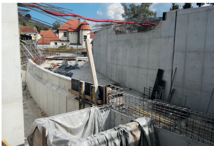
2018, Gradnja podvoza v območju železniške postaje Poljčane
