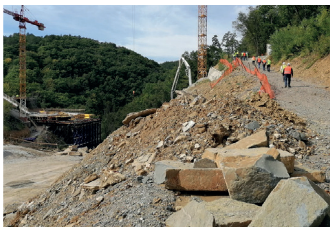
2021, vkop predora na T1 in Viadukt Glinšica
