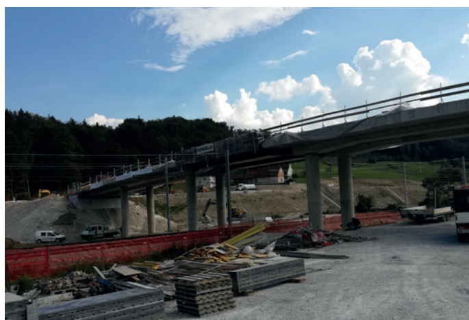
2018, Ogled gradnje nadvoza Breznica
