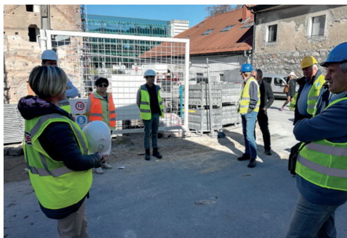
2020, Ogled gradbišča obnova Cukrarne
