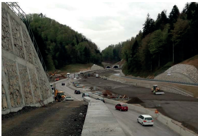
2019, Ogled gradnje ceste G1-9, območje Gruškovja
