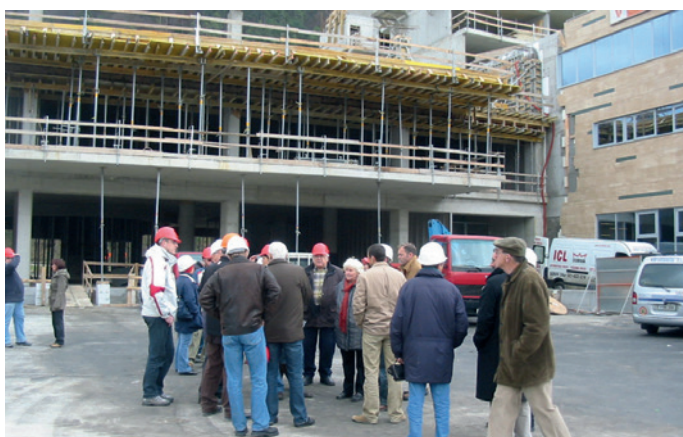
2006, ogled gradnje Thermana v Laškem
