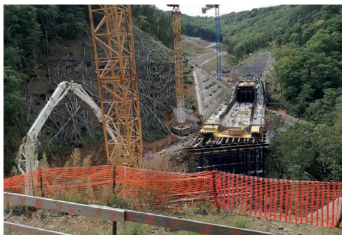
2021, vkop predora na T1 in Viadukt Glinšica
