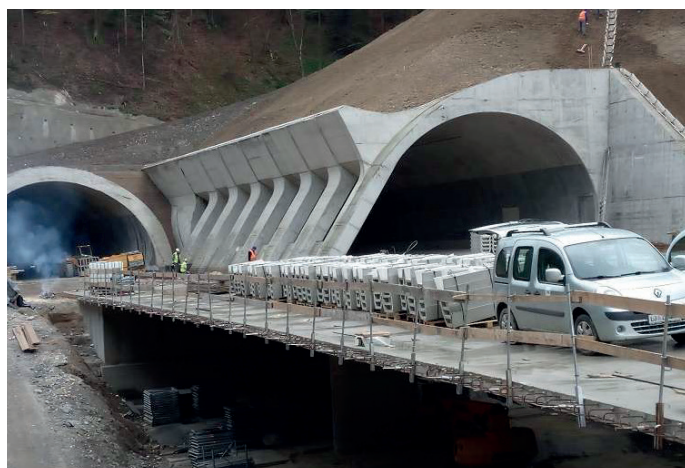
2019, Ogled gradnje ceste G1-9, območje Gruškovja
