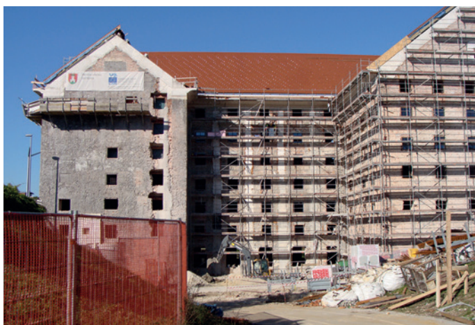
2020, Ogled gradbišča obnova Cukrarne
