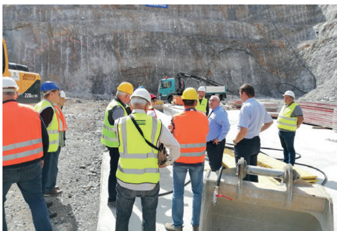
2021, vkop predora na T1 in Viadukt Glinšica
