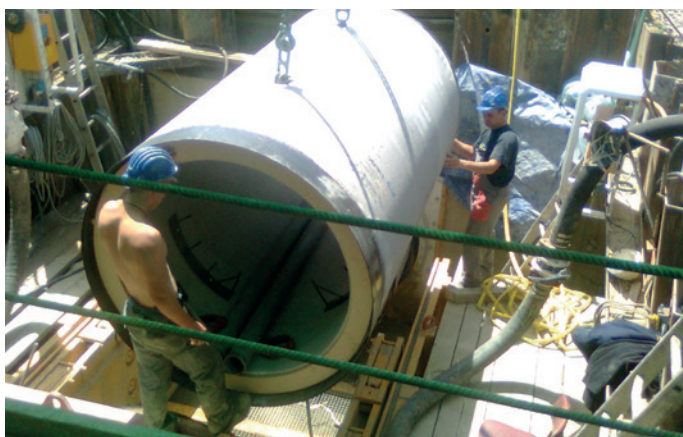
2001, izvajanje hidravličnega podvrtanja
