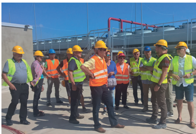
2019, Ogled gradnje objekta Logistični center LIDL
